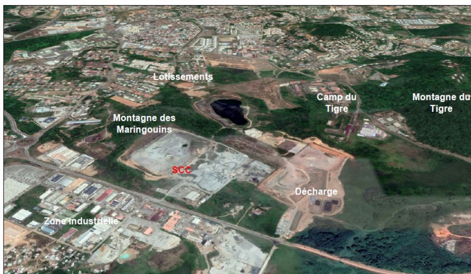
Figure 10 : Vue vers le Nord
